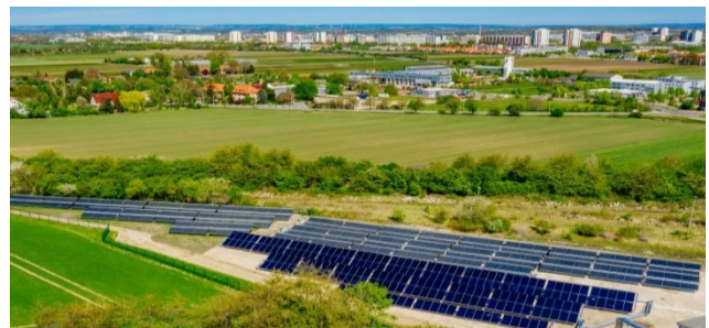
Abb. 10: Zwei Kollektorfelder für Fernwärme in Erfurt
