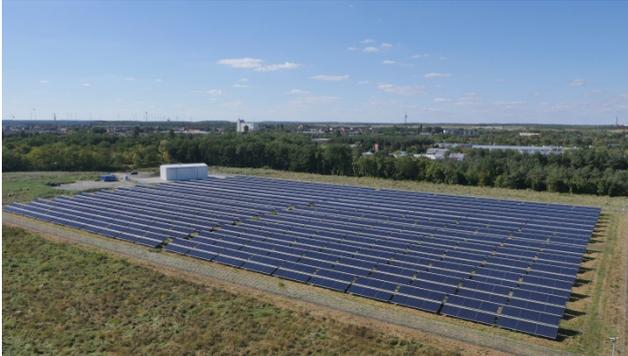
**Abb. 7: Kollektorfeld und Wärmeübergabestation (WÜST)**
