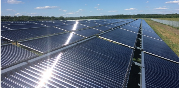
Abb. 1: Kollektorfeld für Fernwärme in Senftenberg
