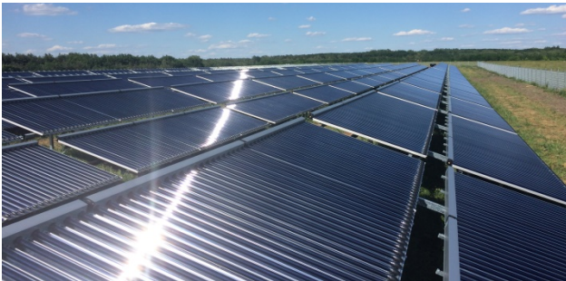
Abb. 1: Kollektorfeld für Fernwärme in Senftenberg
