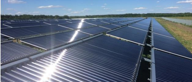
Abb. 1: Kollektorfeld für Fernwärme in Senftenberg
