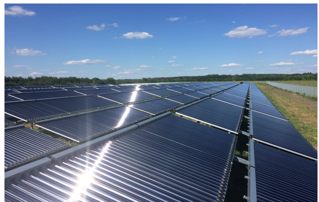
Abb. 2: Kollektorfeld für Fernwärme
