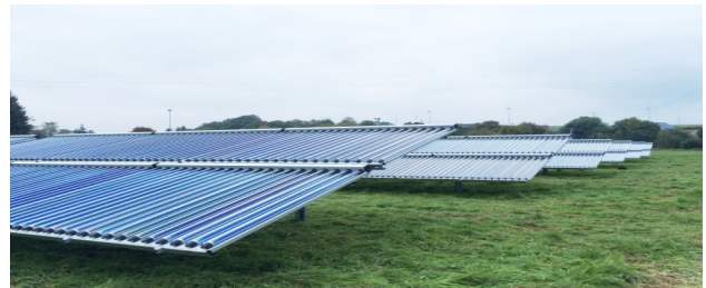
Abb. 15: Verschattungsarme Ständerung von CPC-VRK
