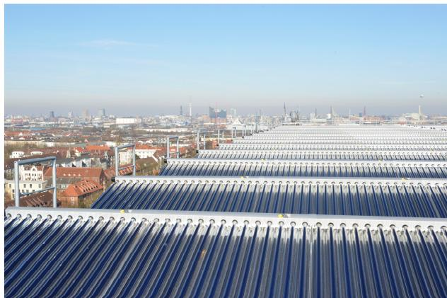
Abbildung 7: Thermische Solaranlage im Wärmenetz von Hamburg-Wilhelmsburg
