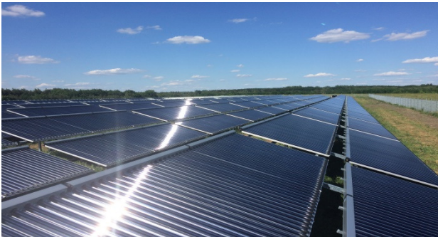
Abb. 1: Das Kollektorfeld in Senftenberg
