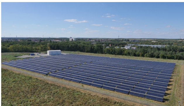
Abb. 7: Kollektorfeld und Wärmeübergabestation (WÜST)
