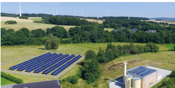
Bio-Solardorf mit Nahwärme Neuerkirch-Külz 2016
