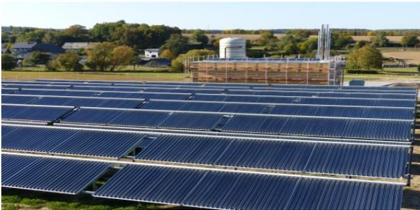
Abb. 13: Bio-Solardorf mit Nahwärme Ellern 2018
