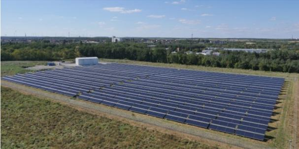
**Abb. 7: Kollektorfeld und Wärmeübergabestation (WÜST)**
