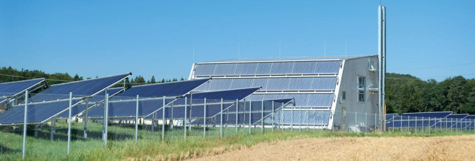
Kollektorenfeld in Büsingen mit zusätzlichen Kollektoren an der Fassade des Kesselhauses
