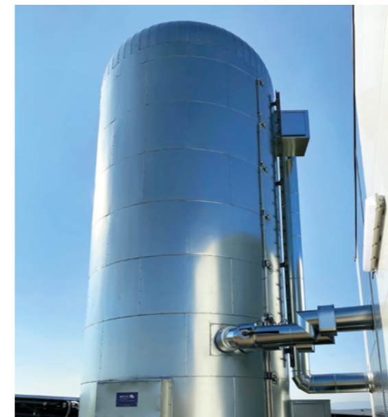
Wärmespeicher 75 m 3
