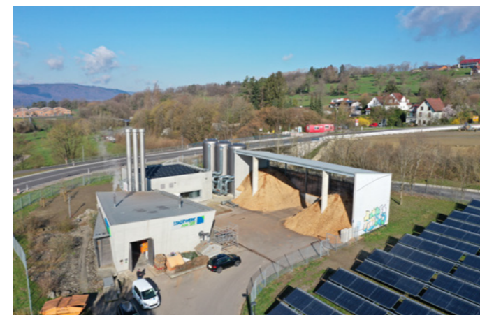
Wärmestation | Foto: Stadtwerke am See GmbH & Co. KG
