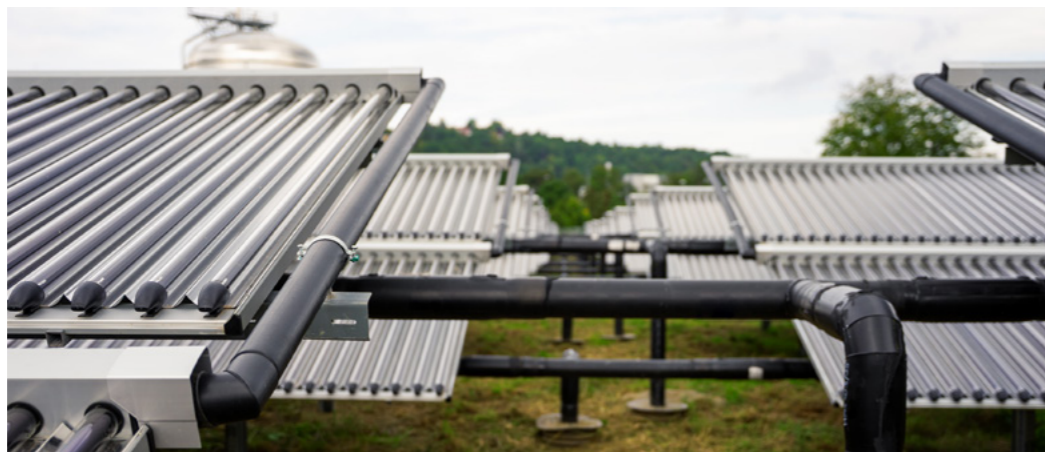
CPC-Vacuumröhrenkollektoren Ritter XL 19/49
