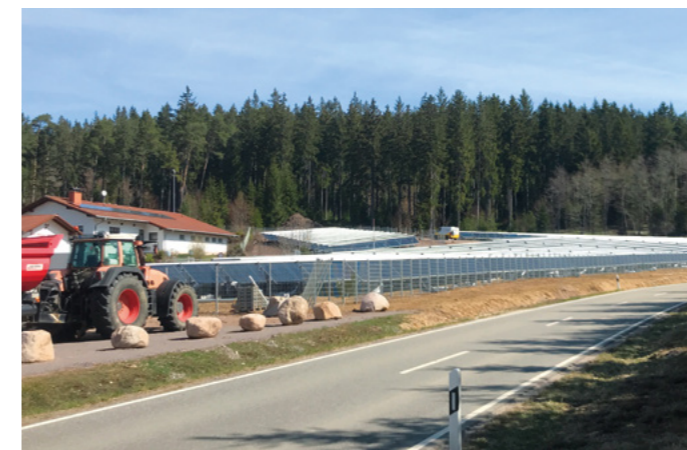
Kollektorfeld ohne Blendwirkung für den Straßenverkehr
