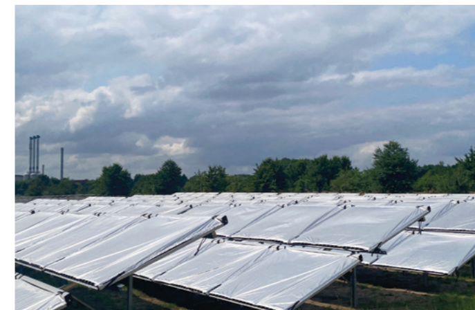
Kollektorfeld, noch mit Abdeckplanen
