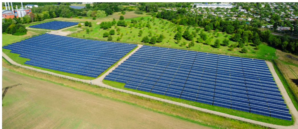
Kollektorfeld mit Heizkraftwerk Helmshäger Berg im Hintergrund | Foto: Stadtwerke Greifswald GmbH
