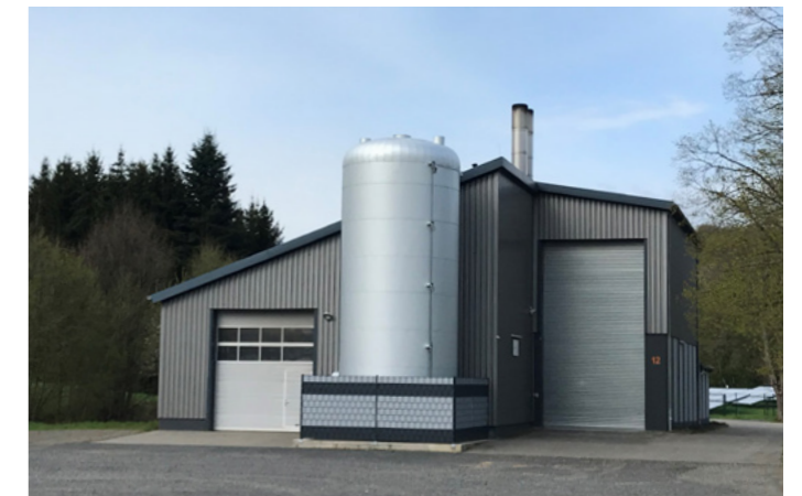
Heizzentrale mit Wärmespeicher
