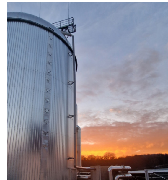
Der Wärmespeicher umfasst 1.250 m 3
