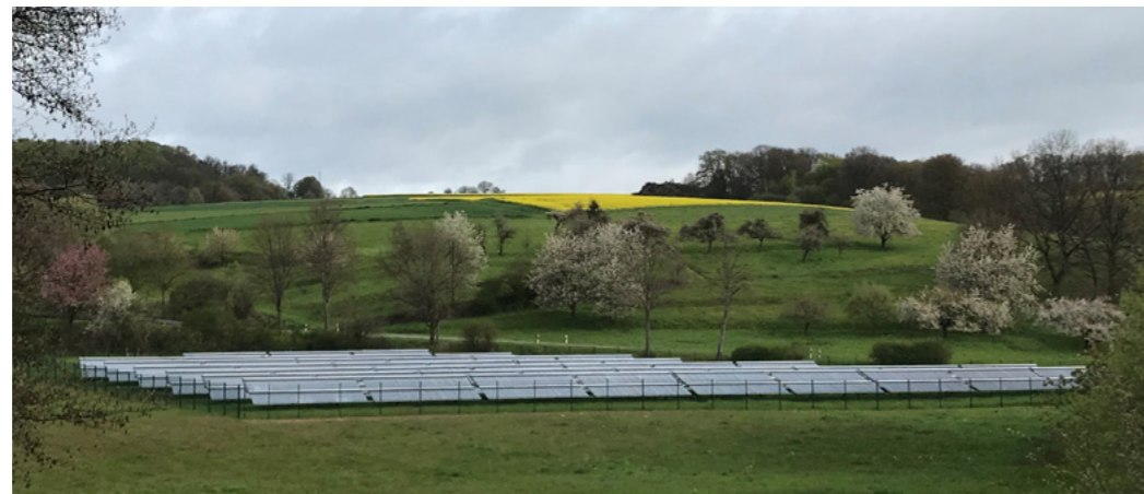
Das Kollektorfeld in Bergheim
