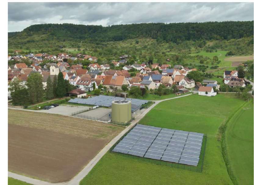
Vogelblick auf die zwei Kollektorfelder und den Speicher mit 1.000 m 3
