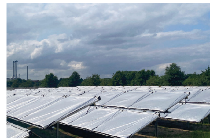
Kollektorfeld, noch mit Abdeckplanen
