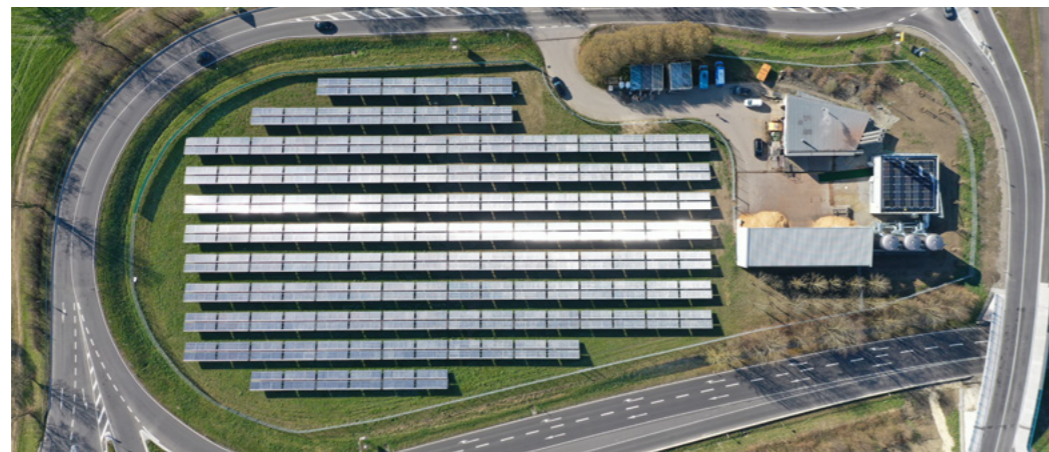
Kollektorfeld von oben | Foto: Stadtwerke am See GmbH & Co. KG
