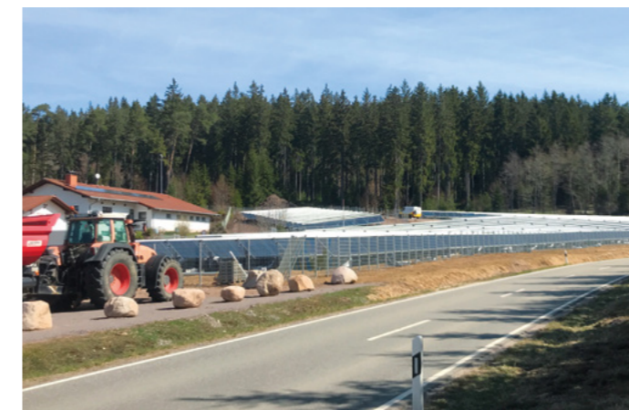
Kollektorfeld ohne Blendwirkung für den Straßenverkehr
