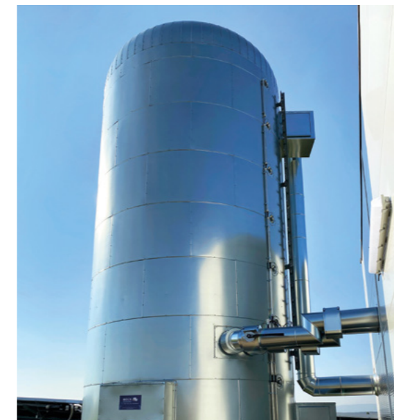
Wärmespeicher 75 m 3
