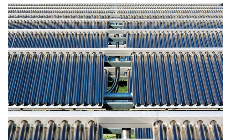
CPC-Vakuumröhrenkollektoren Ritter XL 19/49 | Foto: Guido Broer
