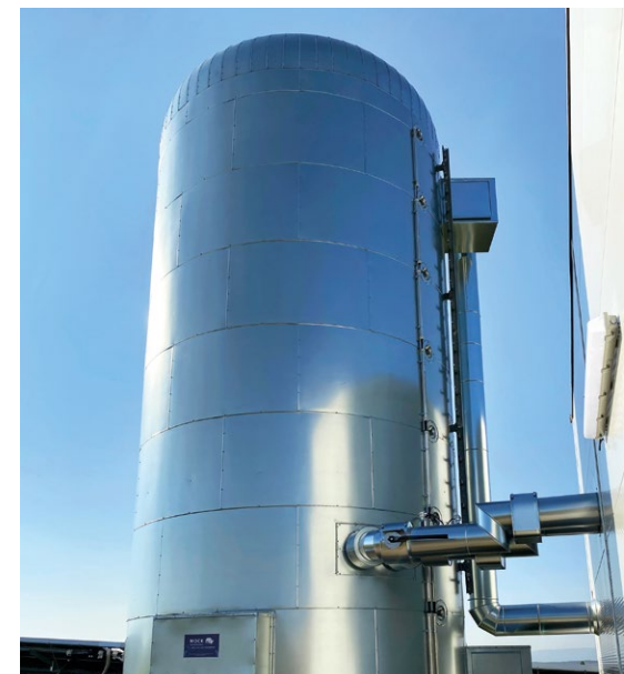
Wärmespeicher 75 m 3
