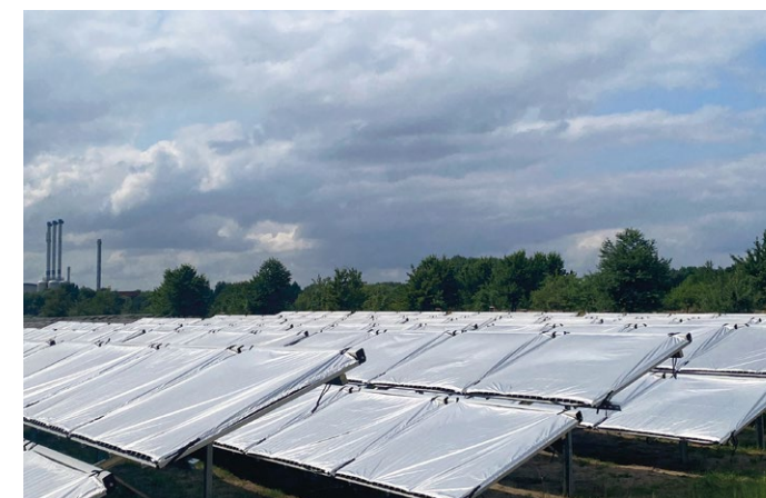
Kollektorfeld, noch mit Abdeckplanen
