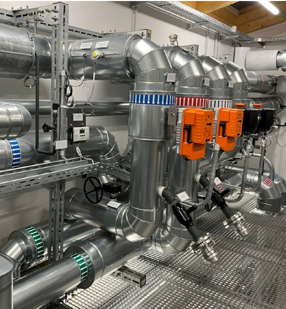
Rohrleitungen und Motorventile in der Solarstation – hier wird die Anlage geregelt und die Wärme ins Netz übertragen
