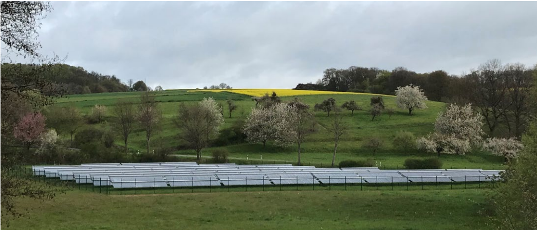
Das Kollektorfeld in Bergheim
