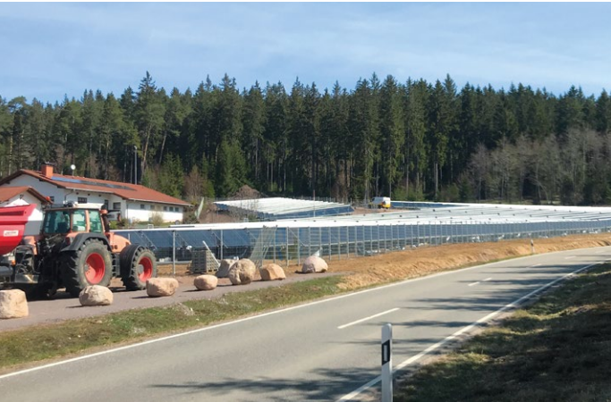
Kollektorfeld ohne Blendwirkung für den Straßenverkehr
