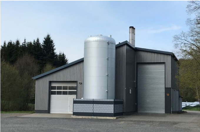
Heizzentrale mit Wärmespeicher
