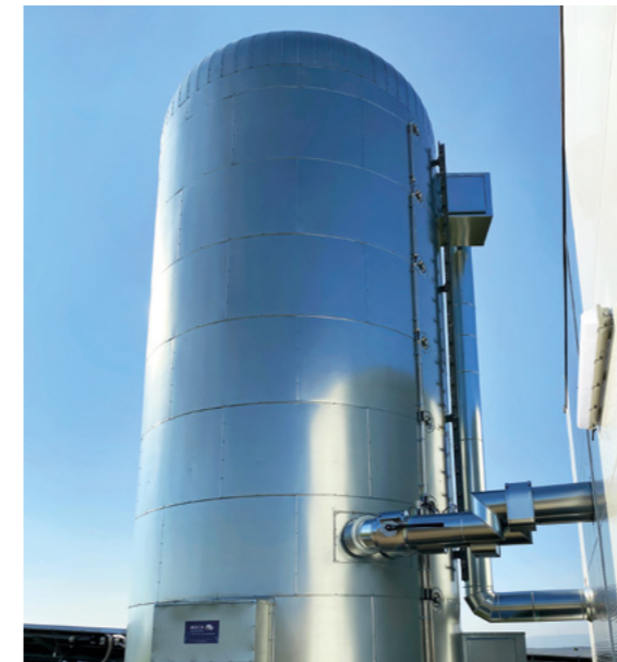
Wärmespeicher 75 m 3
