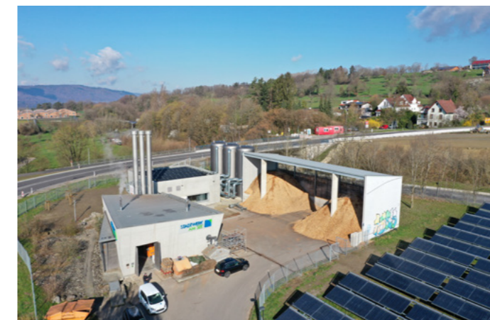
Wärmestation | Foto: Stadtwerke am See GmbH & Co. KG
