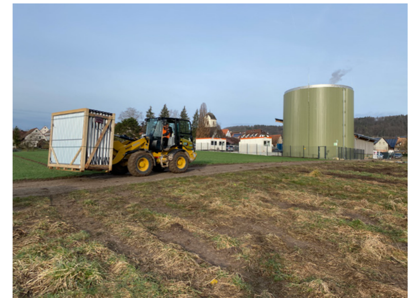
Anlieferung der mit Wasser betriebenen Hochleistungs-Vakuumröhrenkollektoren
