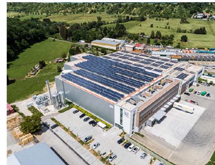
Solarthermieanlage von oben | Foto: Stadtwerke Tübingen
