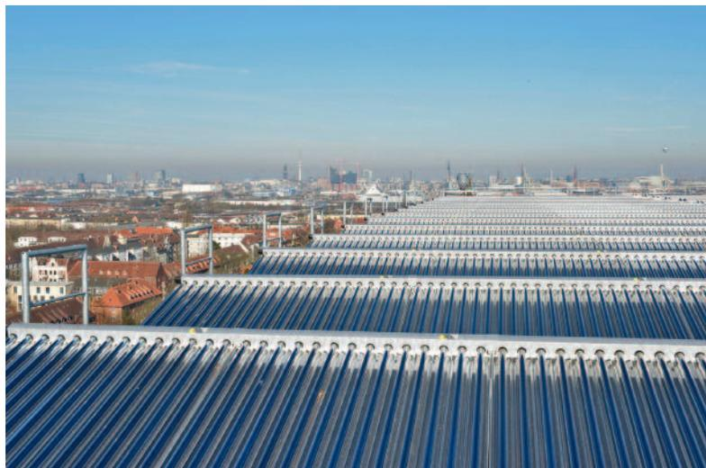
Bild 7 • Thermische Solaranlage im Wärmenetz von Hamburg-Wilhelmsburg
