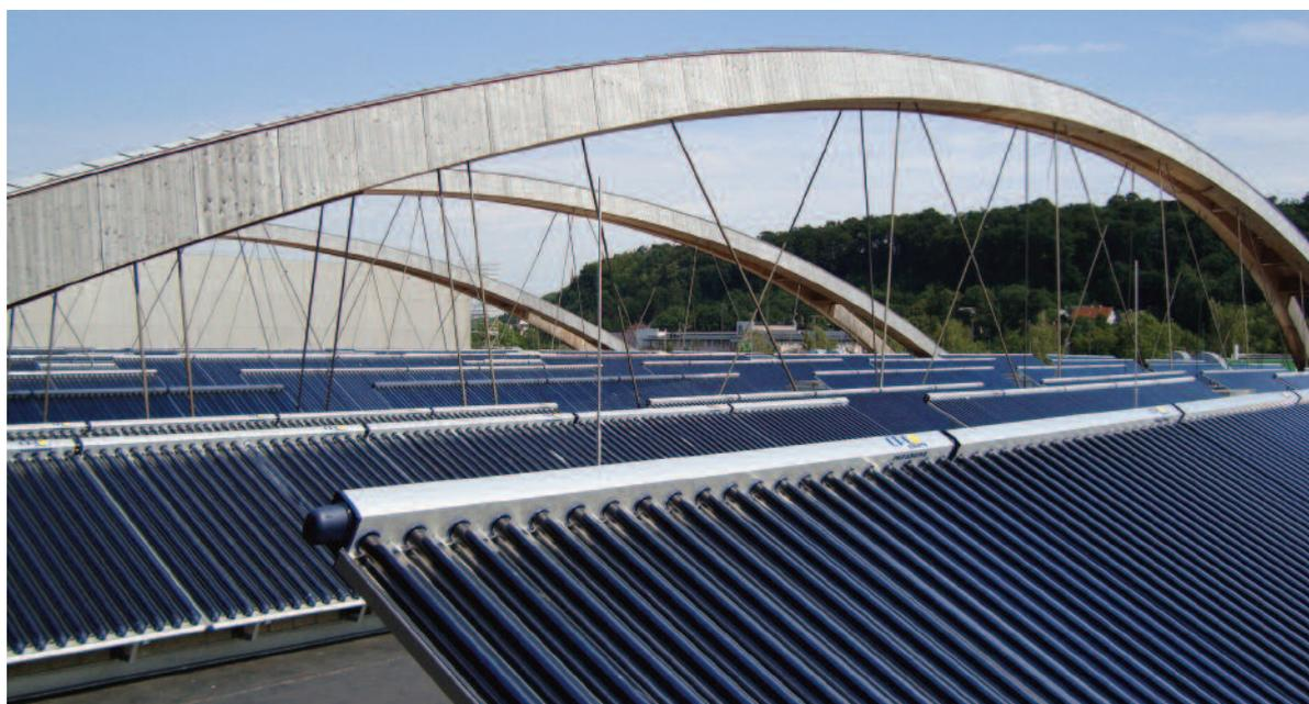
Bild 5 • Dezentrale Einspeisung von ca. 1,3 GWh/a bei 75-100 °C vom Dach der Messe ins Fernwärmenetz Wels (Österreich) mit 3388 m<sup>2</sup> CPC-VRK ohne Speicher seit 2011
