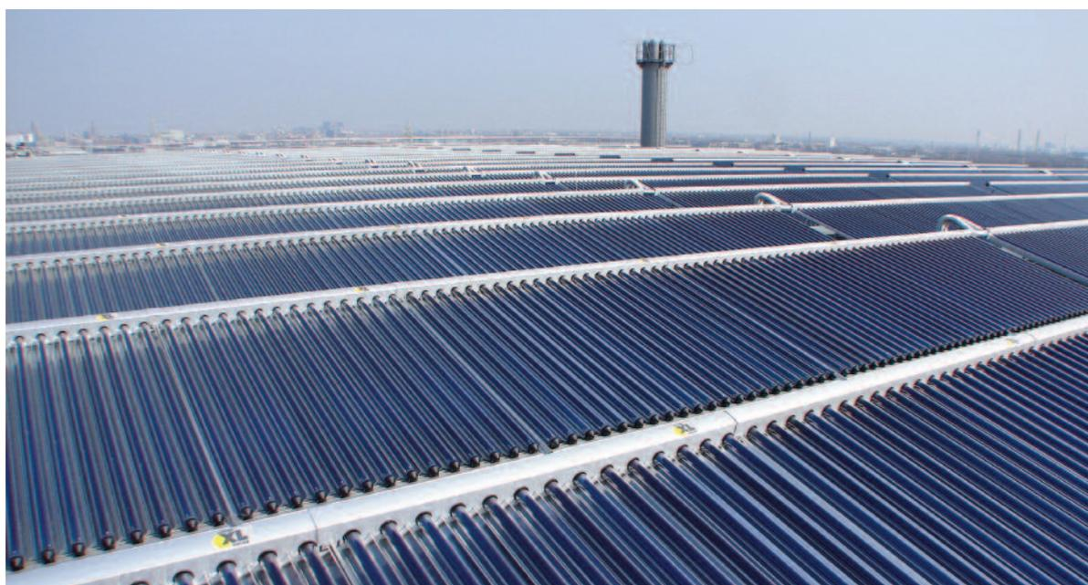
Bild 6 • Zentrale Einspeisung von ca. 550 MWh/a bei 70-95 °C vom Energiebunker ins Fernwärmenetz Wilhelmsburg mit 1348 m<sup>2</sup> Plasma CPC-VRK und 2000 m<sup>3</sup> Speicher, ein Projekt der IBA Hamburg 2013
