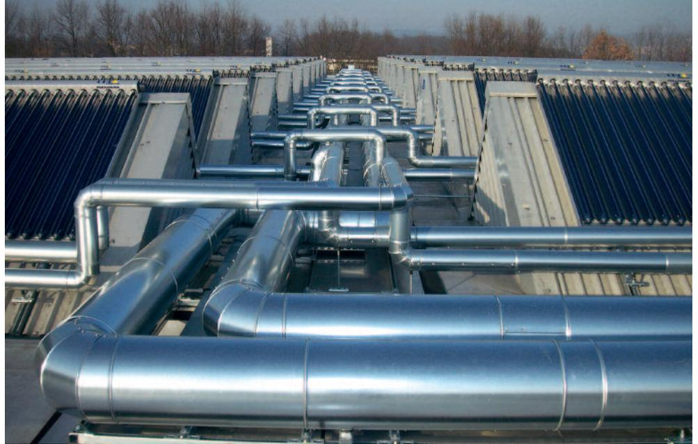
Bild 8 • Zentrale Einspeisung von ca. 550MWh/a bei 80-95 °C in ein Nahwärmenetz in Büsingen (Deutschland/Schweiz) mit 1090 m<sup>2</sup> Plasma-CPC-VRK seit 2013
