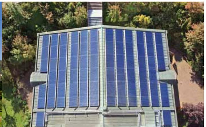
Im Kurstift Bad Brückenau übernehmen CPC-Vakuüm-Röhrenkollektoren die Schwimmbadwassererwärmung.
