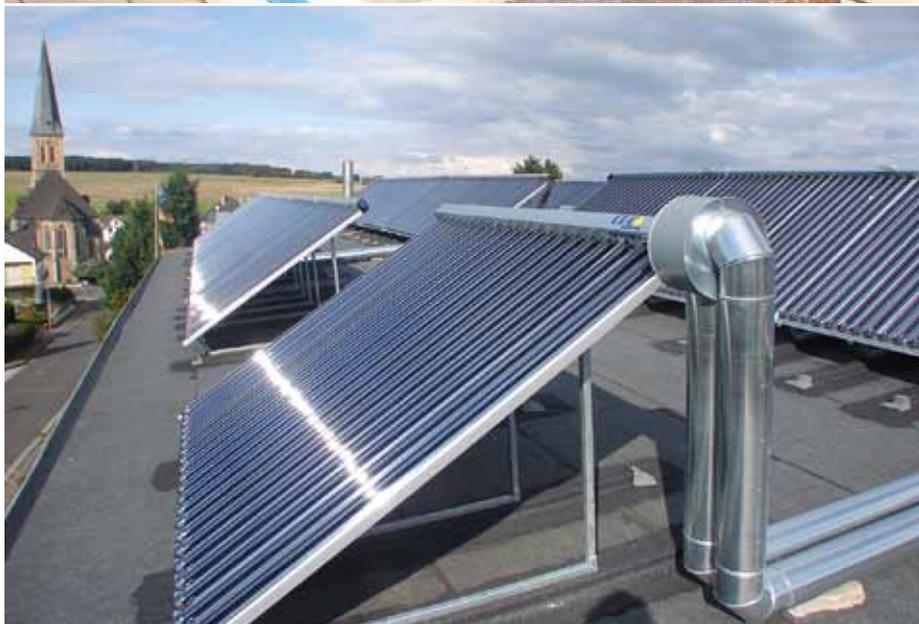
In der „Panorama Sauna“ in Grafschaft Holzweiler sind 98 m<sup>2</sup> CPC-Vakuümrohrenkollektoren installiert.
