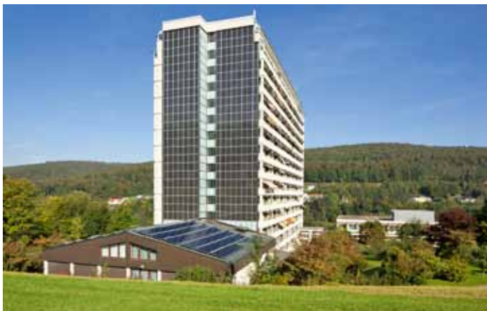
Im Kurstift Bad Brückenau übernehmen CPC-Vakuüm-Röhrenkollektoren die Schwimmbadwassererwärmung.
