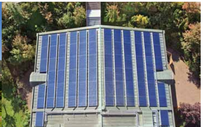
Im Kurstift Bad Brückenau übernehmen CPC-Vakuüm-Röhrenkollektoren die Schwimmbadwassererwärmung.
